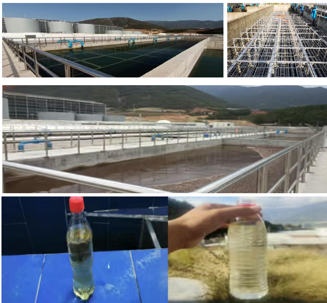
图 8 现场工程施工及运行效果图
